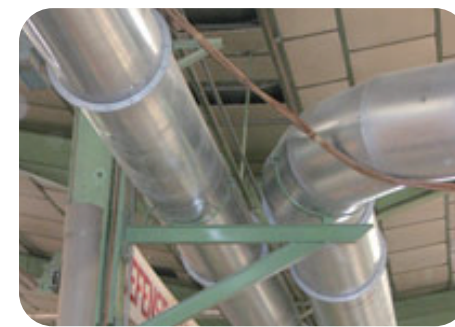
• 镀锌管 - 由法兰连接
