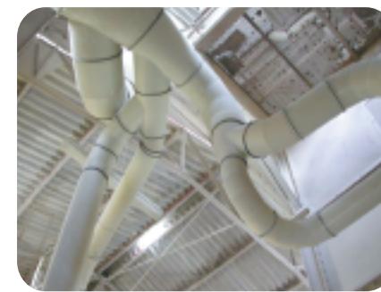
• 油漆喷涂管路 - 由卡箍连接
