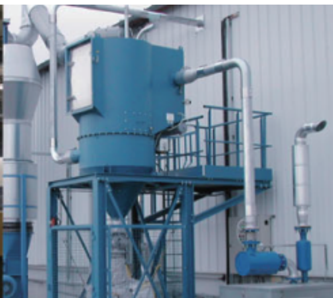
• 中央式高负压吸尘系统除尘单元
